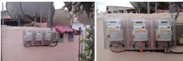
Figura 4 - Instalação dos Medidores Eletrônicos Inteligentes
