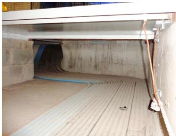
Figura 2- Disposição dos condutores na canaleta
