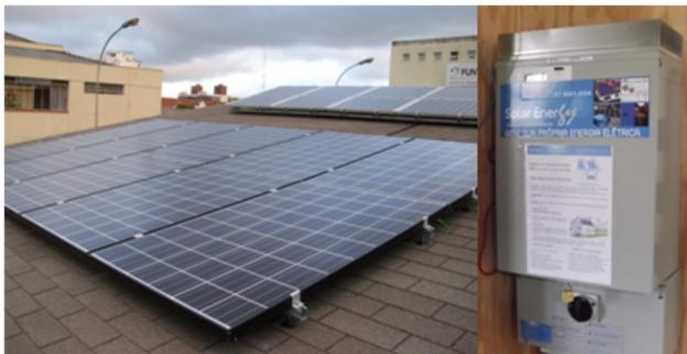
Figura 2 - Painel FV e inversor do EV da UTFPR
