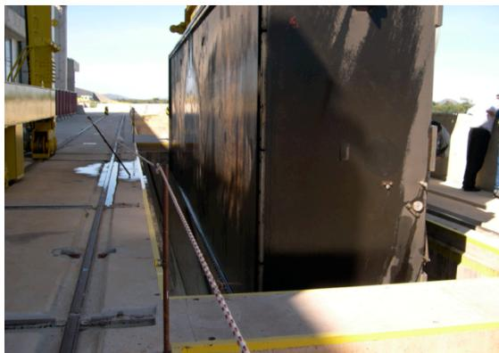
Figura 2. Ilustração da colocação do *stop log*.
