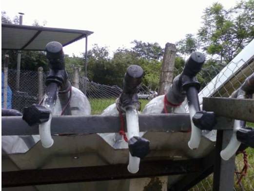
Fig. 1 - Torneiras para a regulagem da vazão.
