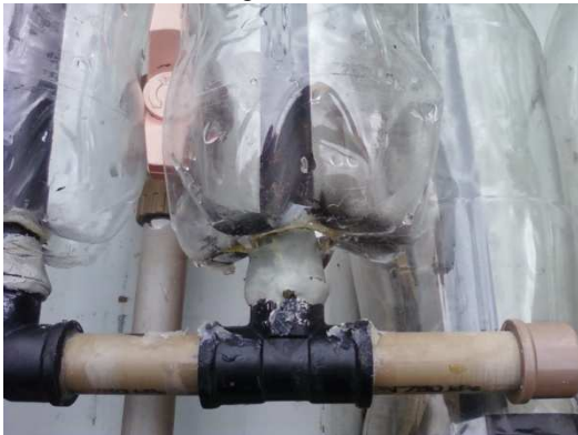
Fig. 2 - Vedações com epóxi.
