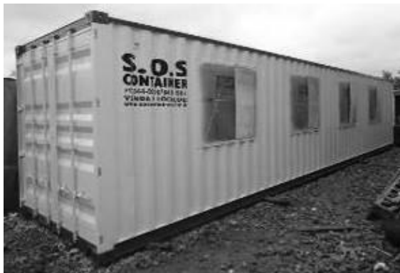
Figura 1- Instalação de contêiner ISO em obra. Fonte: www.soscontainer.com.br .
