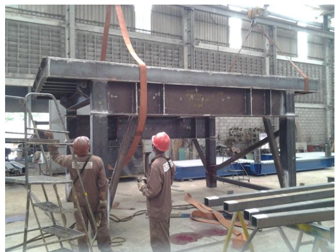
Figura 2. Construção e montagem da subestrutura.
