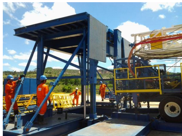
Figura 1. Subestrutura da SPT.
