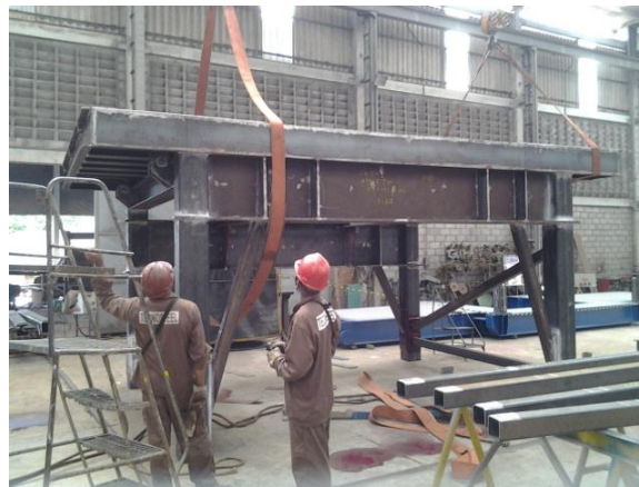
Figura 2. Construção e montagem da subestrutura.
