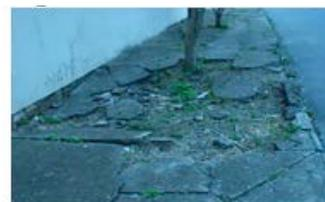
Figura 3 - Erosão no trecho 2 da quadra 6
